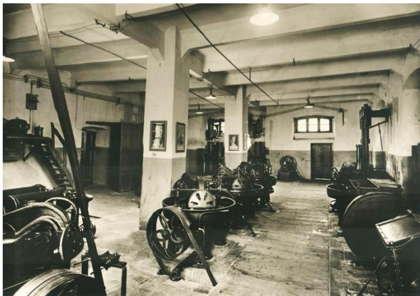
Torre Annunziata, 1931, pastificio Giovanni Voiello di Via Maresca. Veduta d'insieme di alcune macchine del salone delle trafilè e della sala per le macchine per la gramola e laminatoi. Immagine utilizzata per una delle litofotografie della serie cartoline illustrate *Molino Pastificio Voiello*. Foto Industria Arte Fotografica di Attilio Maiorana, Napoli.
