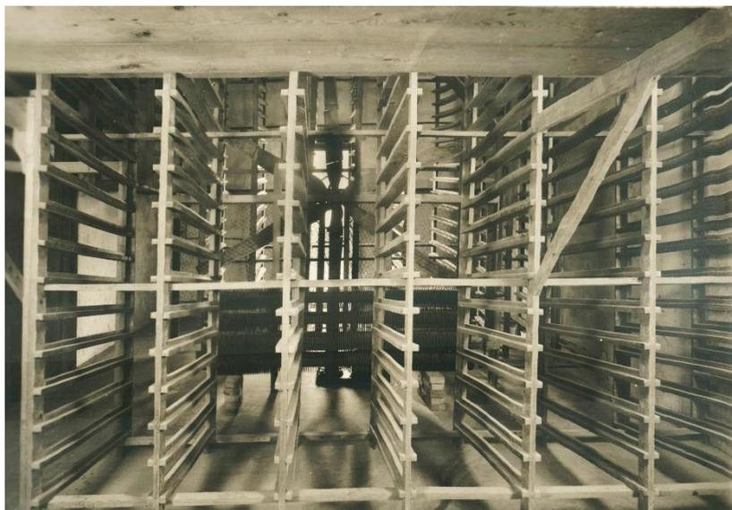
Torre Annunziata, 1931, pastificio Giovanni Voiello in Via Maresca. Telai di una delle camera di essiccazione per le “paste fini” (corte). Immagine utilizzata per una delle litofotografie della serie cartoline illustrate *Molino Pastificio Voiello*. Foto Industria Arte Fotografica di Attilio Maiorana, Napoli. ASB-FV.
